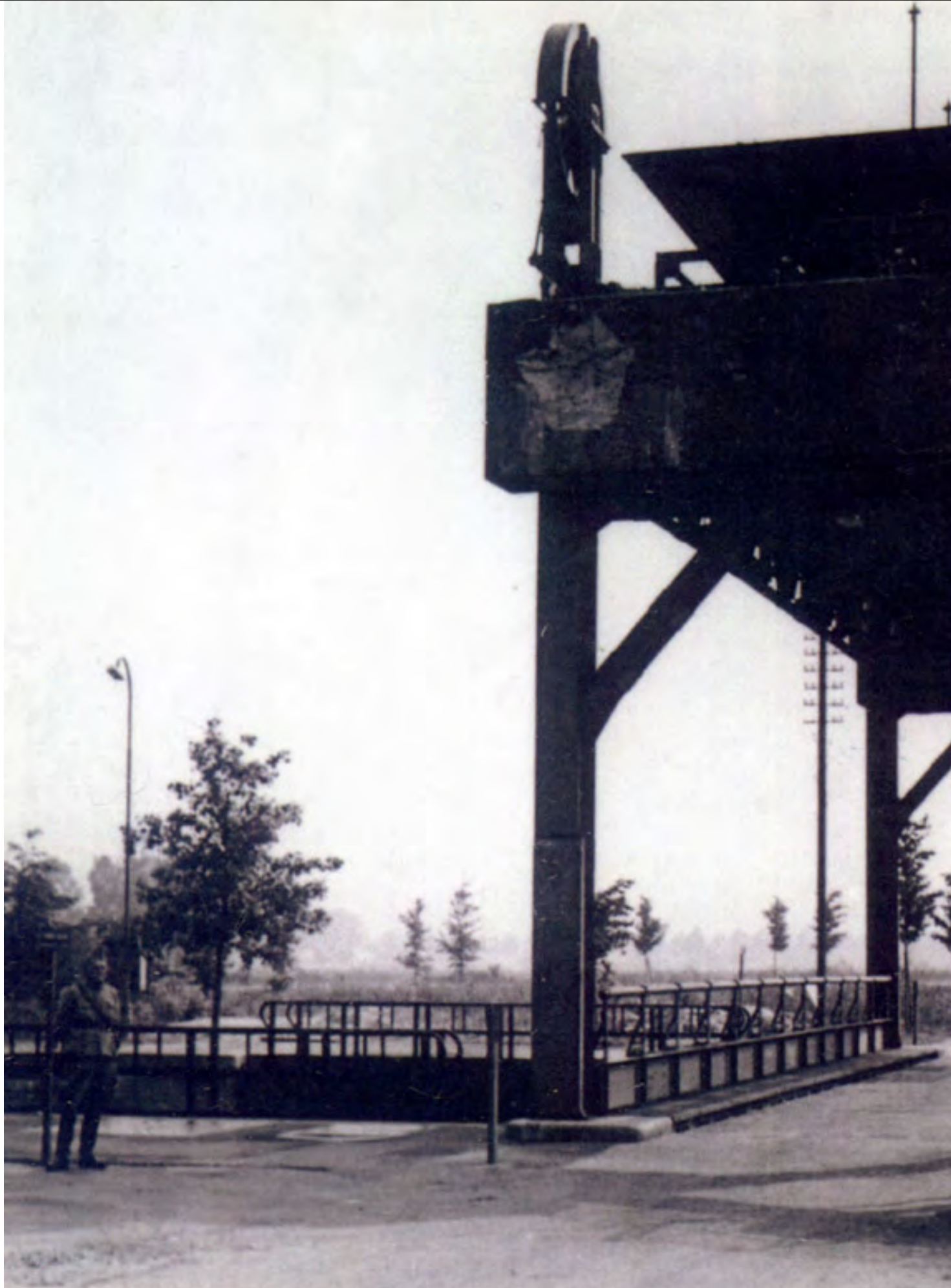
Op 10 mei 1940 bestookt het Nederlandse leger de Heumense Brug om zo de opmars van de Duitse troepen te stagneren. Op het betonnen tegengewicht van de hefbrug is de inslag van een mortier zichtbaar. (Uit: E.P Weber, De vuurproef van het grensbataljon )
