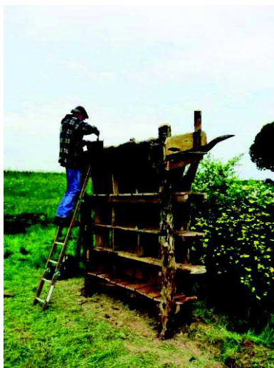
Afwerking plaggendak door Jef Gielen op 17 mei Dassengebied Sluisweg
