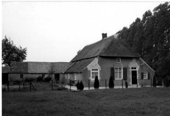
Stapperskamp in 1984 na herstel van brandschade door blikseminslag
