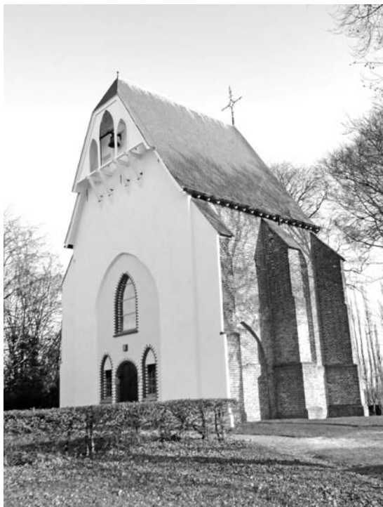
Na de gedeeltelijke sloop in 1710 bleef het koordeel van de 15 de eeuwse R.K. parochiekerk van Overasselt over. Foto december 2011
